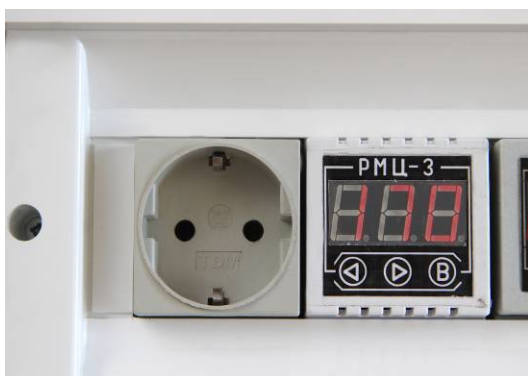
Фото 3 Модуль РМЦ и розетка подключения ТЭНов
